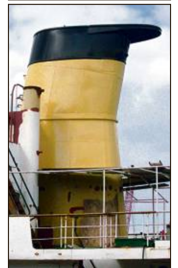
Der Schornstein im Zustand vor und nach der gründlichen Erneuerung.
